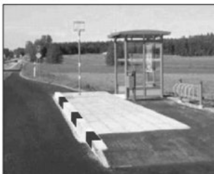
Рисунок 2.19.5 – Пример обустройства остановочного пункта пандусом
